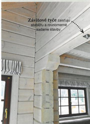
**Presné lepené trámy** sa strojovo vysušia na optimálnu úroveň, čo zaistí ich rozmerovú stálosť. Drevo pride na stavbu bez povrchovej úpravy, ktorú si potom každý stavebník volí sám. Tu sú steny upravené pigmentovaným prírodným olejom.
