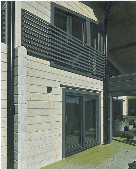
Vodorovne rastrované zábradlie na poschodí je známkou tzv. štýlu Elegance.
